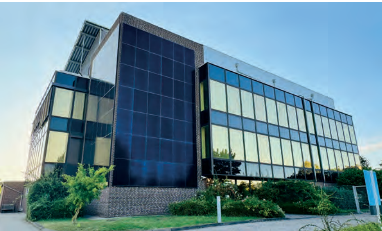
Nachhaltig betrieben: Das GRASS-MERKUR Rechenzentrum in Hannover mit eigener Photovoltaikanlage.
